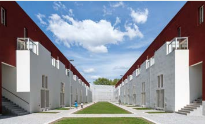
Vues des trois cours intérieures, d’ouest en est. Lors de la première phase de construction dans les années 1970, 56 logements sur 128 ont été réalisés, à l’est de l’opération. Views of the three inner courtyards, from West to East. During the first phase of construction in the 1970s, 56 housing units were built, out of 128, East of the plot.
