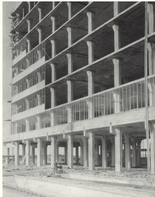
Les huit étages de la fabrique de tabac ont été conçus de manière à permettre le déplacement des machines en fonction des besoins, grâce à une trame minimale, portée par des colonnes octogonales en béton armé et supportant des dalles de béton coulées sur place.
