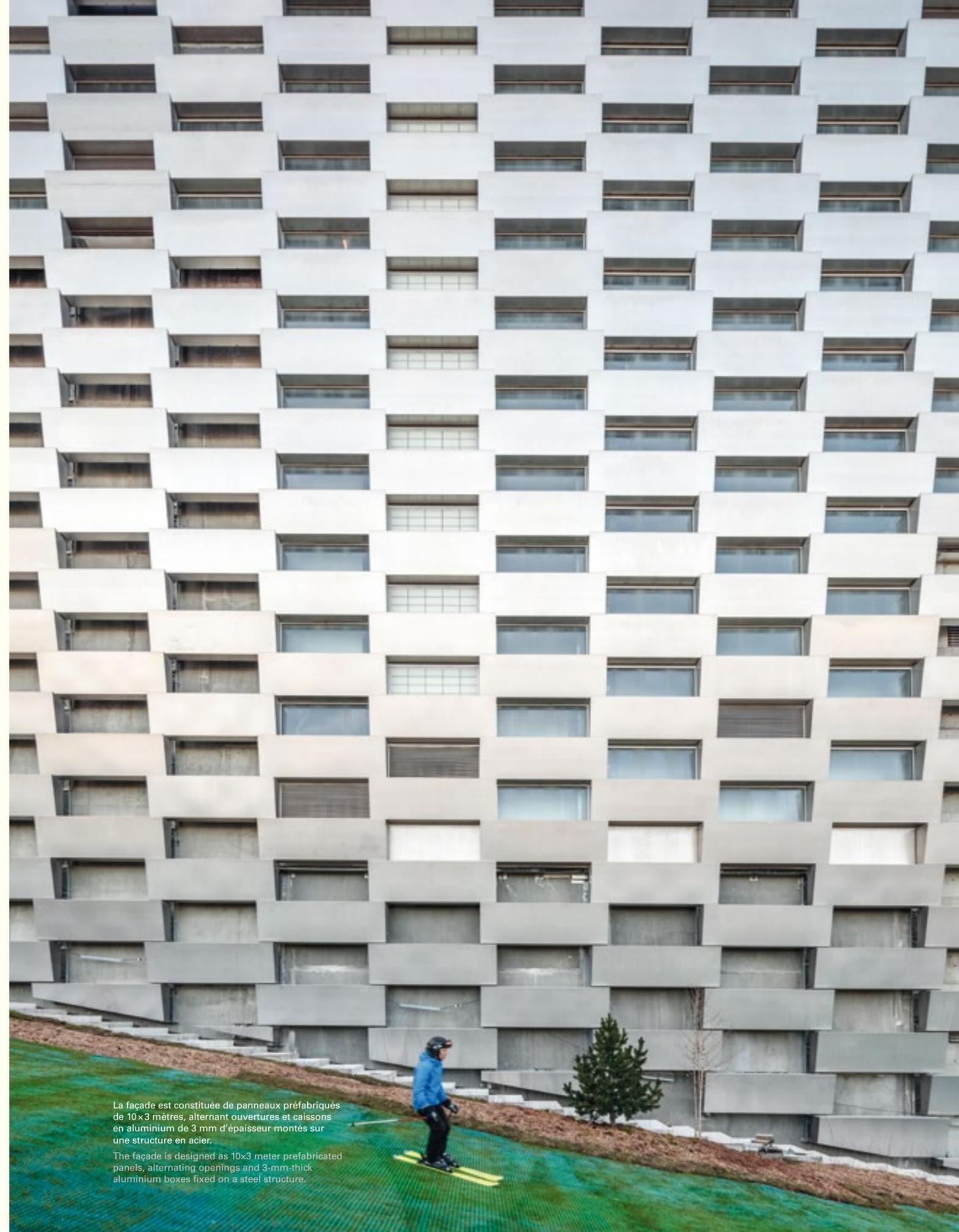
La façade est constituée de panneaux préfabriqués de 10x3 mètres, alternant ouvertures et caissons en aluminium de 3 mm d'épaisseur montés sur une structure en acier.
