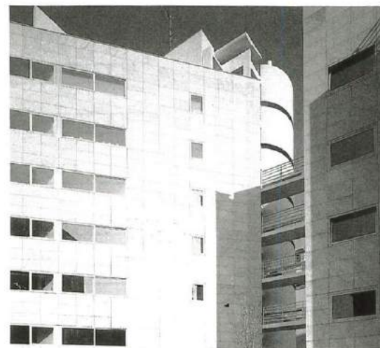
Un escalier en spirale, stoppé dans son élan, en plein ciel.
