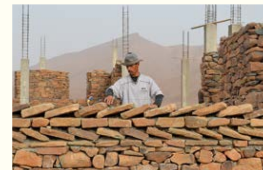
Les murs sont en pierres de gros calibre, alignées sur une structure en béton armé imposée par le code de l'urbanisme.
