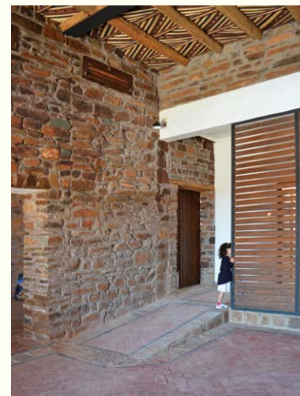
Le bardage de la galerie bioclimatique (à droite) est composé d'un panneau de contreventement en métal sur lequel sont préassemblés les tasseaux de bois. Le plafond est partiellement réalisé en tataoui, une technique de marqueterie marocaine, et assemble du laurier et des stipes de palmier. Au sol, pavage en schistes locaux et stuc marocain s'ajoutent au grès et au ciment teinté.
