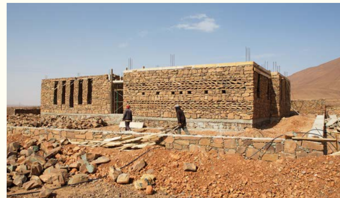
Les murs sont en pierres de gros calibre, alignées sur une structure en béton armé imposée par le code de l'urbanisme.
