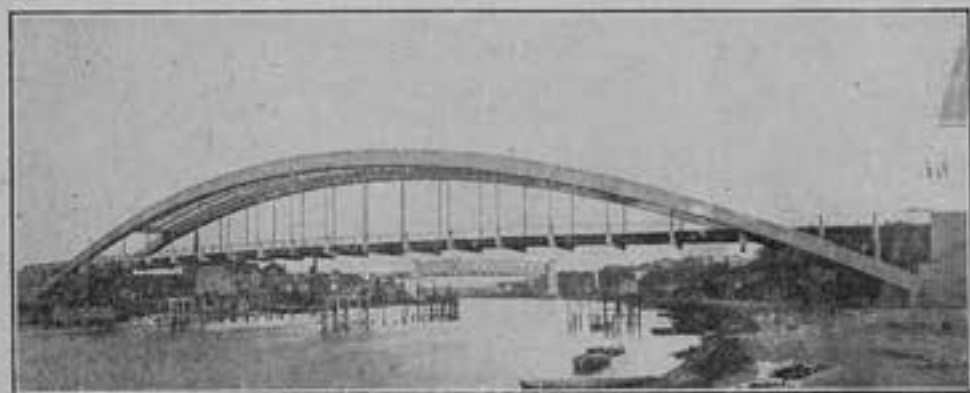
PONT EN BÉTON ARMÉ SUR L'OISE A CONFLANS-FIN-D'OISE Cl. Mon. des Travaux Publics Photo Boussiron
