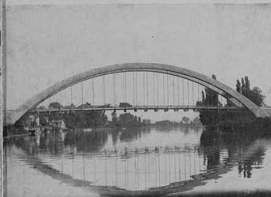
PONT SUR LA SEINE A SAINT-PIERRE DU VAUVRAY RÉALISÉ PAR LA SOCIÉTÉ ANONYME DES ENTREPRISES LIMOUSIN (PROCÉDÉS FREYSSINET)
