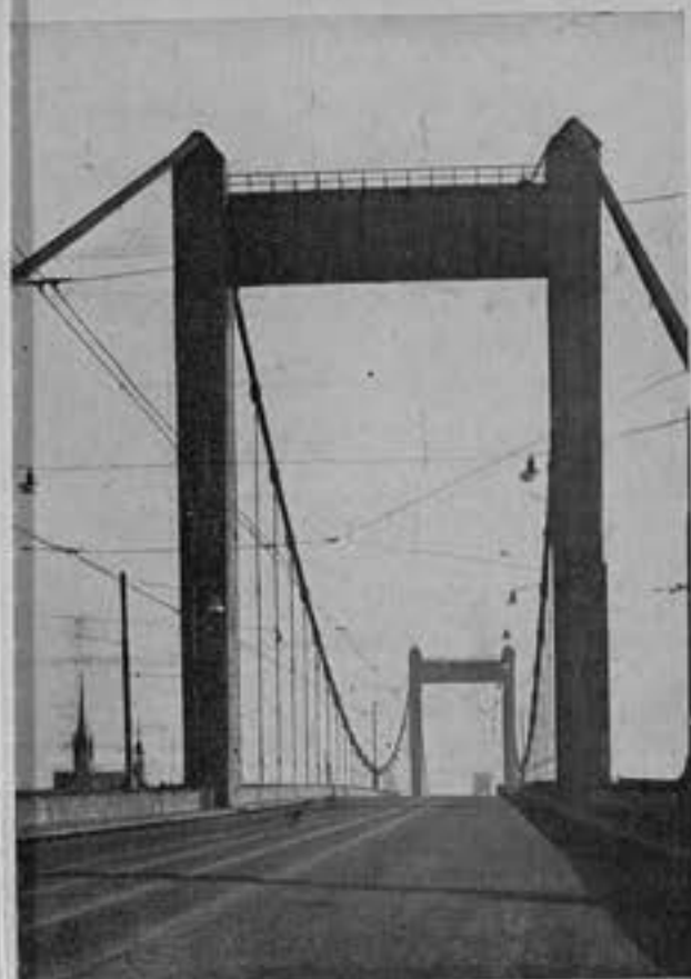
On voit les poutres principales qui supportent la chaussée et forment des parapets
