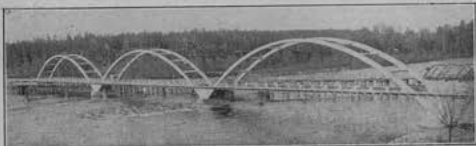
PONT EN BÉTON ARMÉ DE DEJE EN SUÈDE (1929) TROIS TRAVÉES DE 72 m. Photo Christianiet Nielsen
