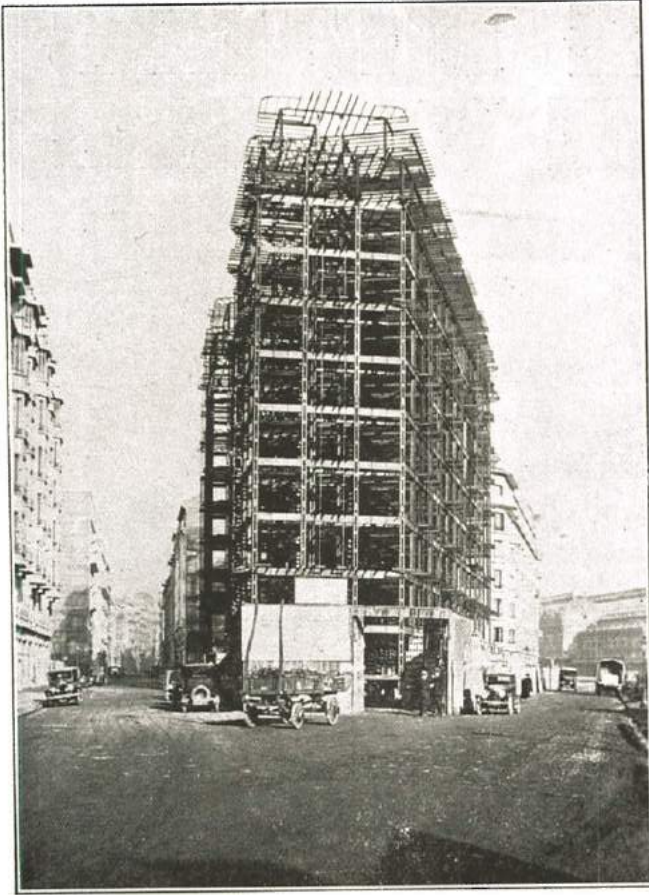
LYON: PALAIS DE FLORE Construction de onze étages. Clément LAVAL Arch.
