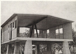
MONTAGE DES PAROIS ET DU TOIT
