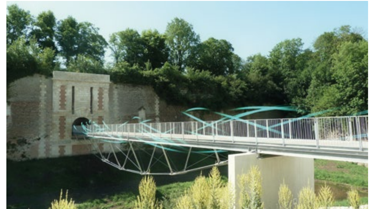
Sur la passerelle d'Abbeville, au nord-est du site, le compositeur évoque « un collier de perles sonores ». Les sons se relaient et glissent le long de la structure métallique.
